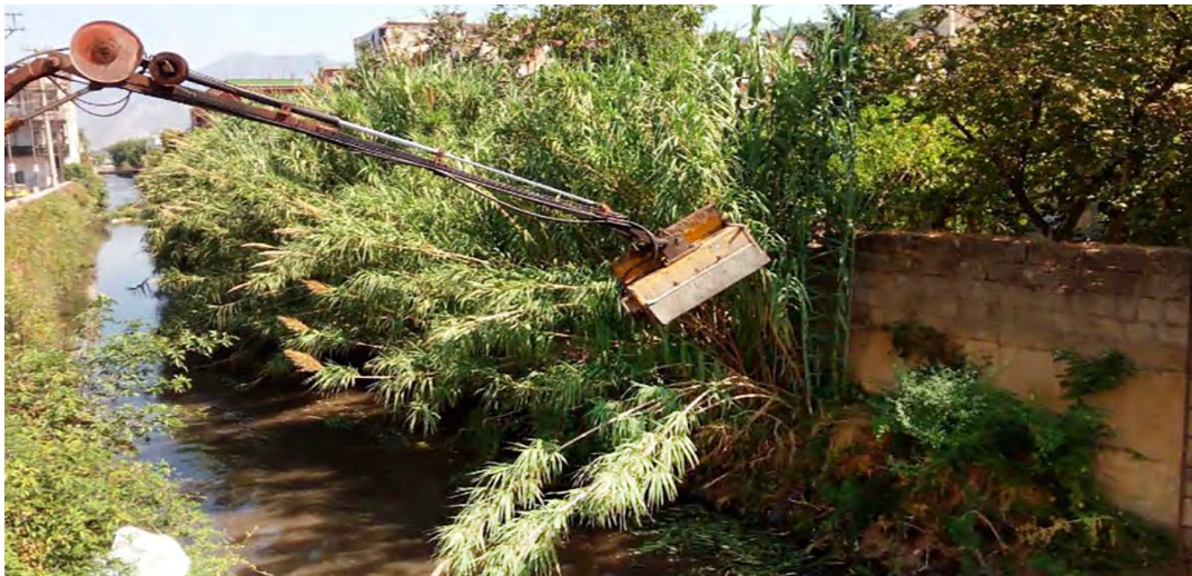
Operazioni di manutenzione pulizia dell'alveo di un fiume, ostruito da detriti e da natura incolta.
